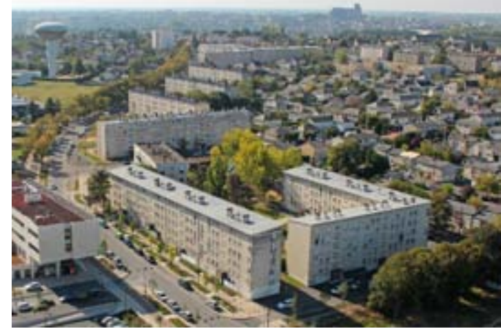
Chancellerie – Bâtiments CR-CU
