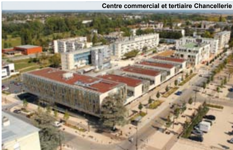
Centre commercial et tertiaire Chancellerie
