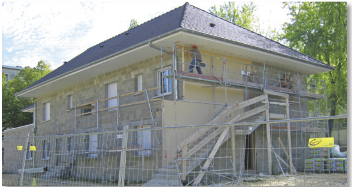
La construction des logements s'accélère
