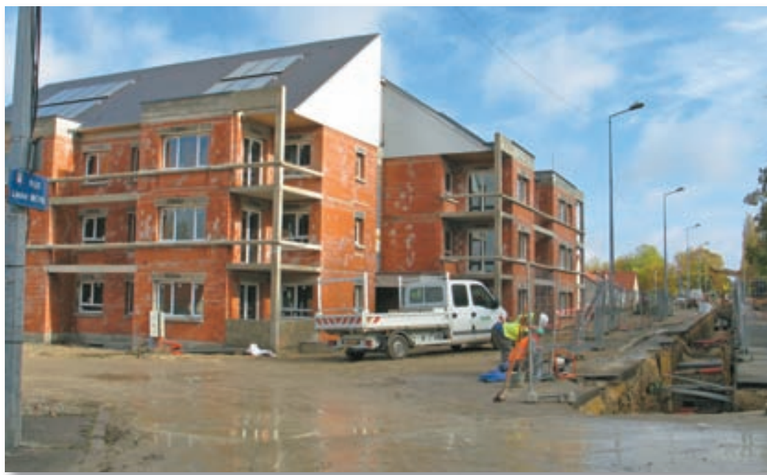
Dernière ligne droite pour la construction
