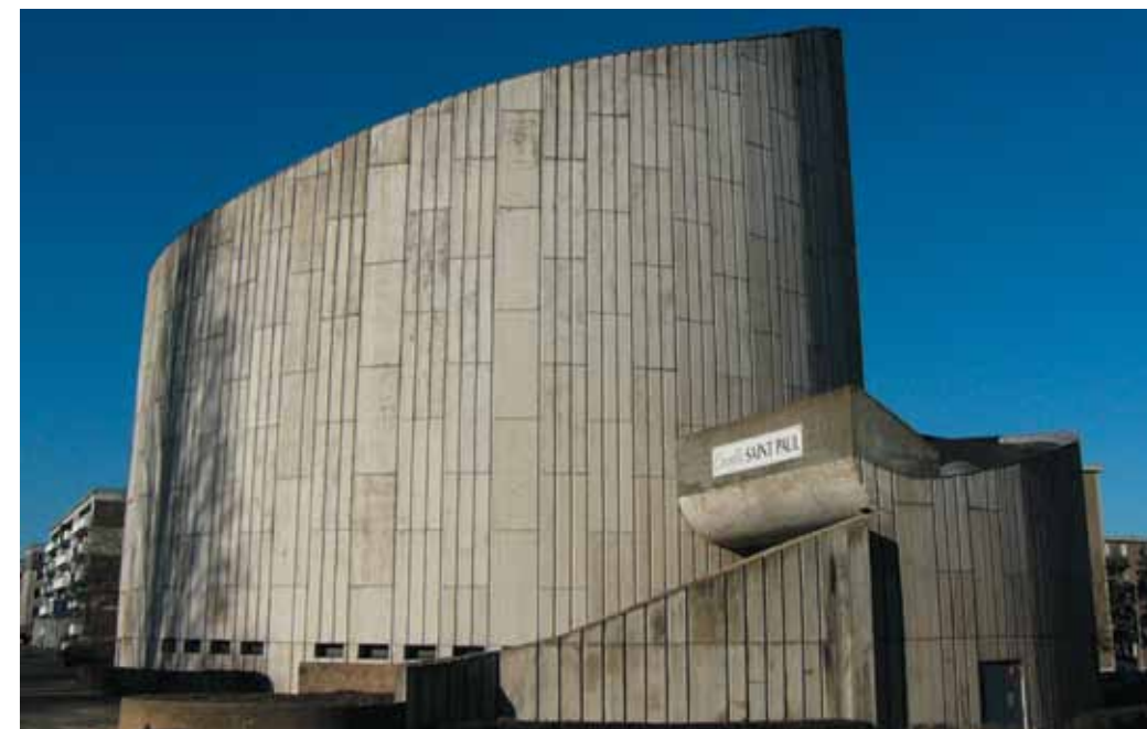
La chapelle Saint-Paul (service patrimoine)
