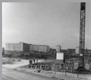
Chemin de grue installé à la Chancellerie (AM Bourges)
