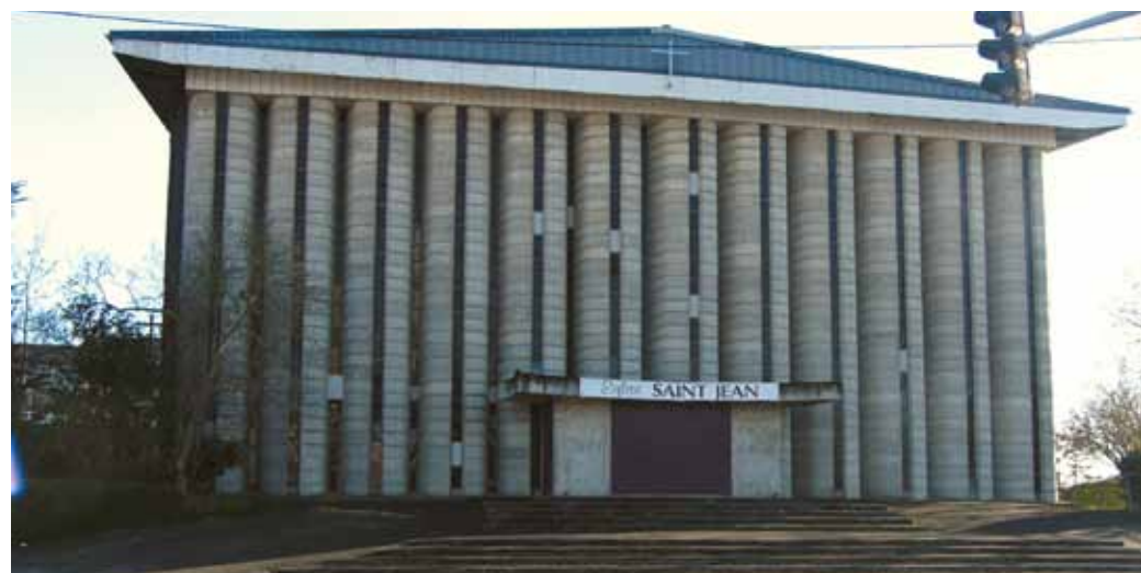
La façade de l'église Saint-Jean (service patrimoine)
