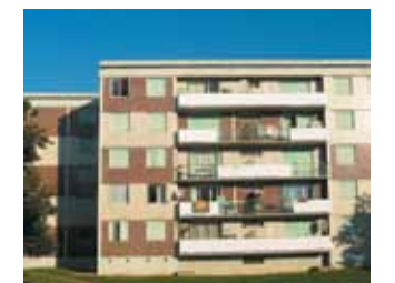
Exemple de préfabrication lourde (immeuble LN) (GIP RU Bourges)
