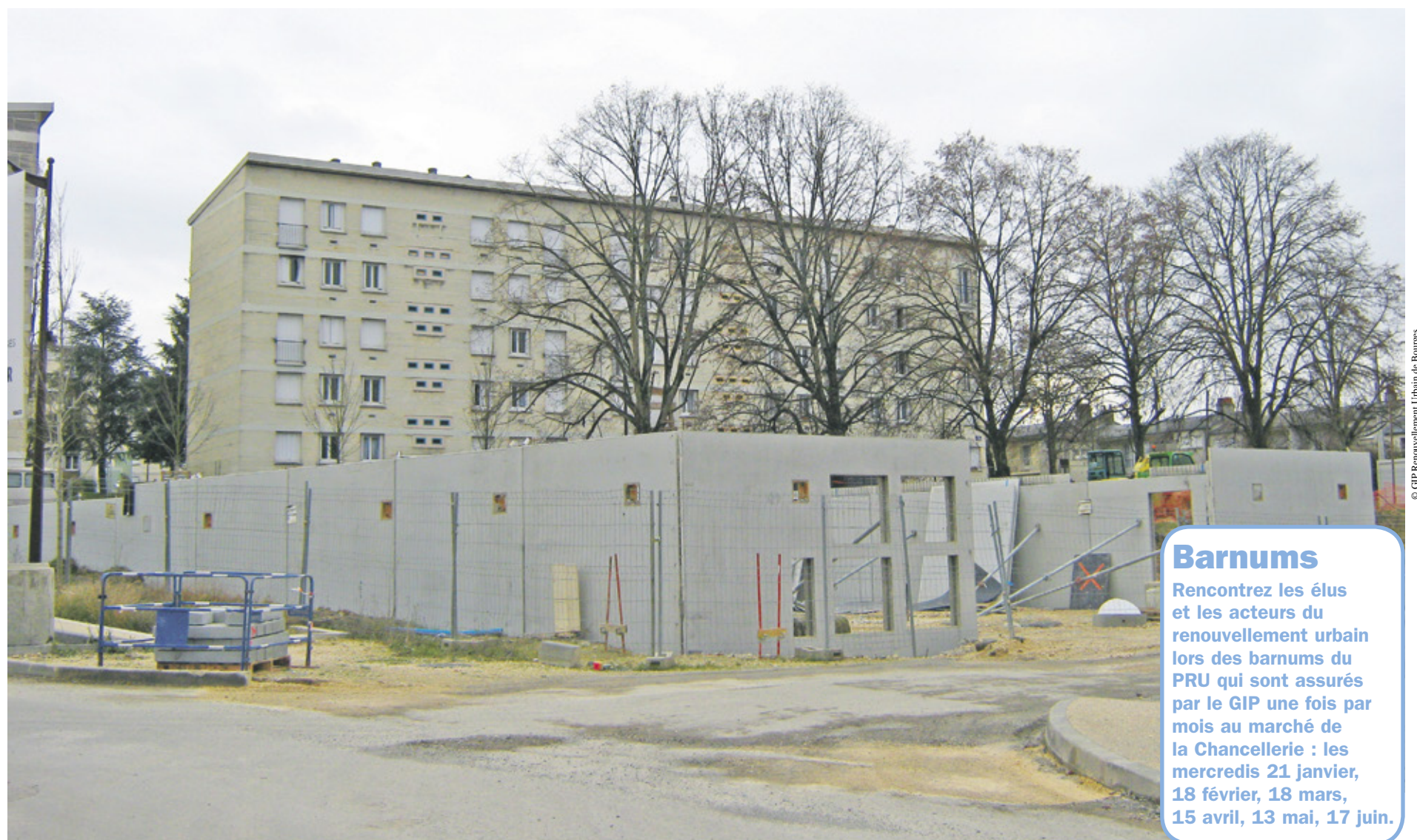
La construction des 23 logements a démarré
