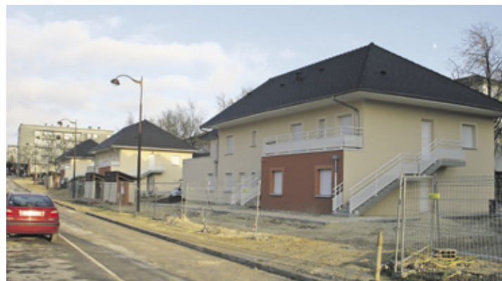
Les travaux touchent à leur fin
