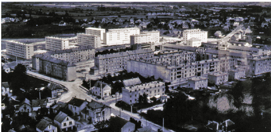
Vue aérienne représentant la Chancellerie en cours de construction
