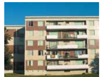
Exemple de préfabrication lourde (immeuble LN) (GIP RU Bourges)
