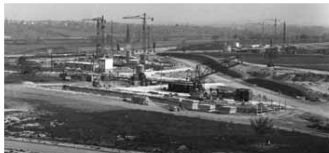
Travaux en cours à la Chancellerie, vers 1960 (AM Bourges)
